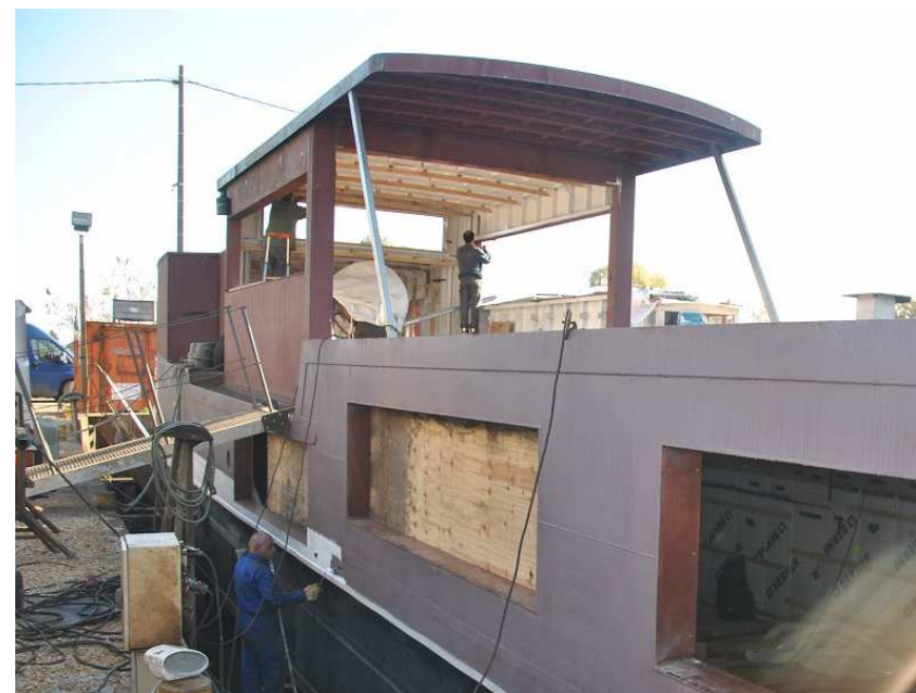
Trois ouvriers rénovent la coque d'une péniche (isolation, peinture) Crédit photo : Collège Les Hautes Pailles
